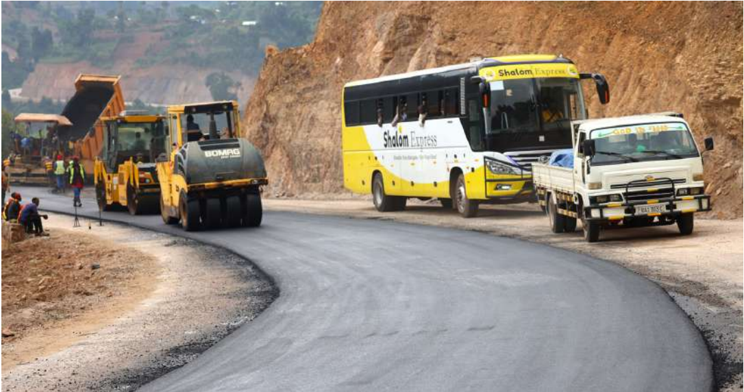
Iyubakwa ry’umuhanda wa kaburimbo Base- Butaro- Kidaho ugeze kuri 54% wubakwa
